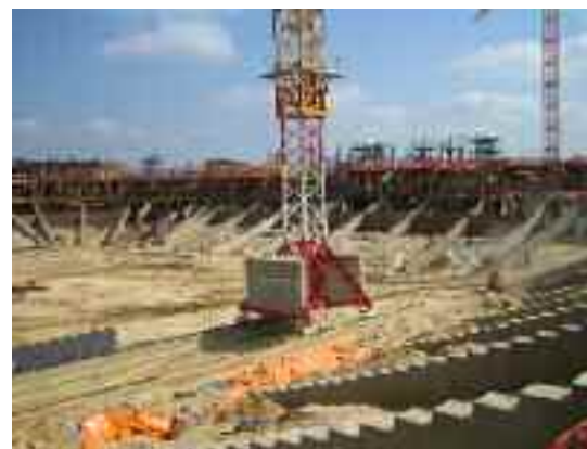
Bau des FIFA-WM-Stadions in Nelspruit
